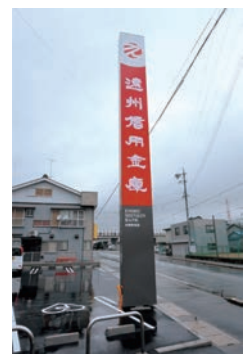
開発した技術により建設した看板 (高さ10m,幅1m,杭長4m)
