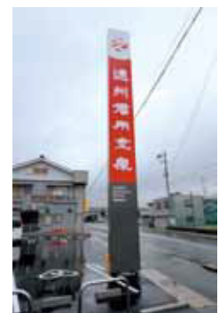
開発した技術により建設した看板 (高さ10m,幅1m,杭長4m)
